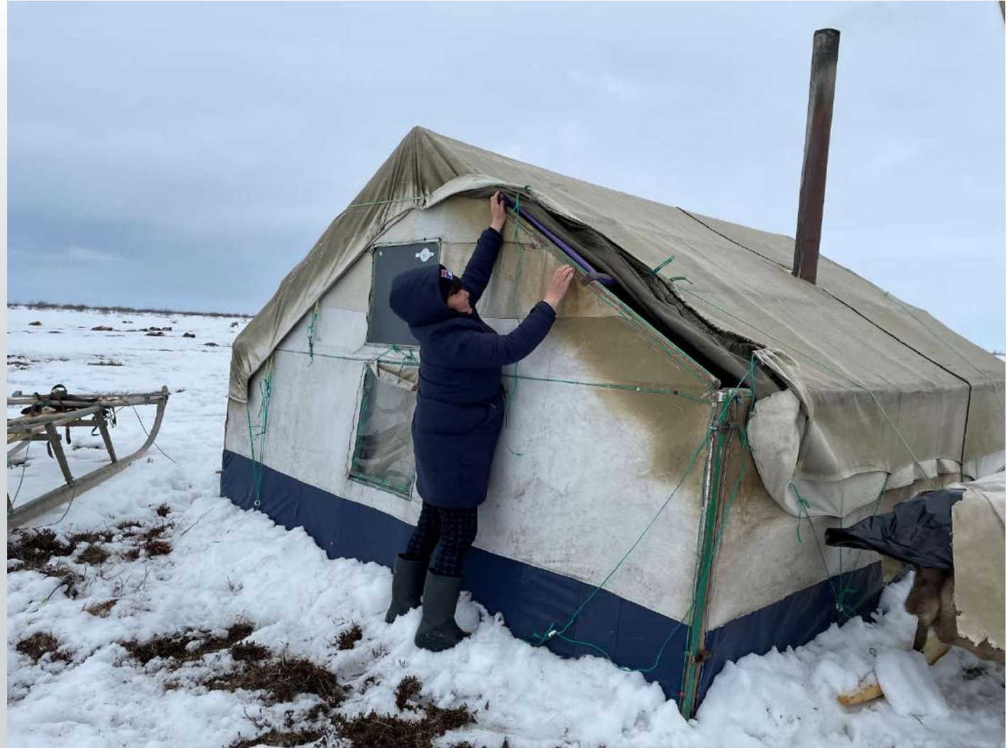
Конструктивные особенности палатки: окно, декорированное веревкой, система креплений (веревки, кольца, замки), двойная крыша
