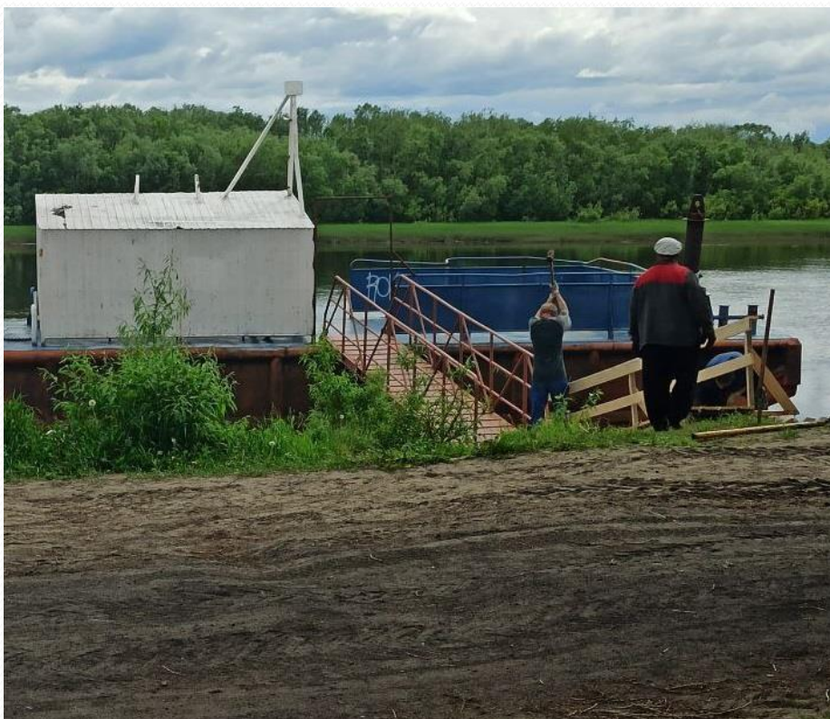
Ремонт причала местными жителями, с. Вознесенье. Фото А. Максимова
