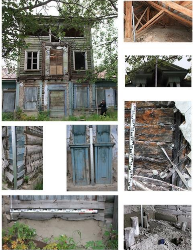
Обмер методом фотофиксации
