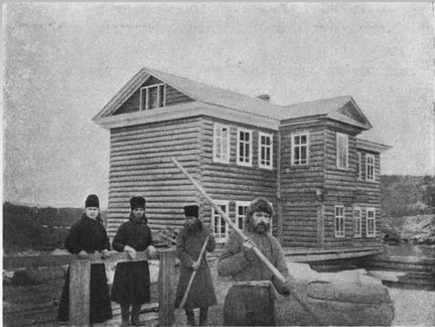
Домъ надъ вододвижимымъ колесомъ, приводящимъ въ движеніе динамо-машину, лѣсопилку и винторѣзно-строгат. ток. станокъ.
