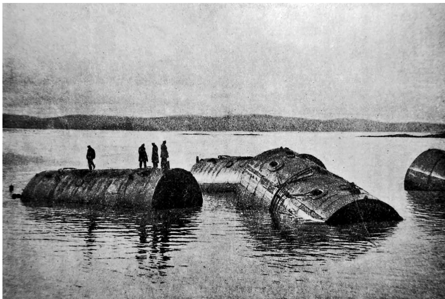
Рис. 5. Понтоны, при помощи которых специалистами ЭПРОНа был поднят «Садко» в 1933 г. 1
